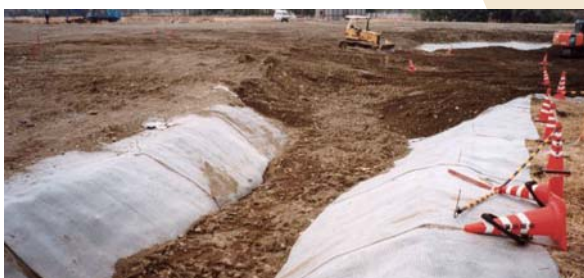
保護土施工状況
