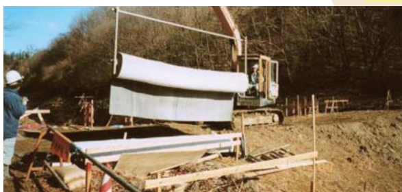
ボルクレイ・マット吊り上げ
