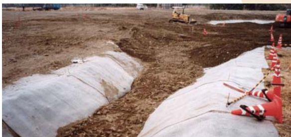
保護土施工状況
