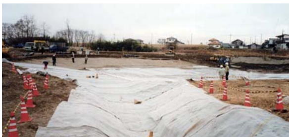
ボルクレイ・マット設置状況
